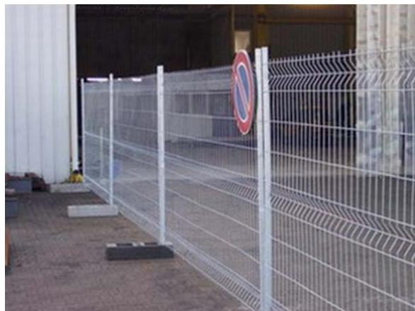
Ograda TIP 1 postavlja se na betonske stope i koristi se za za ogradijanje prostora.
